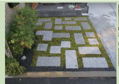
防草シート工事
