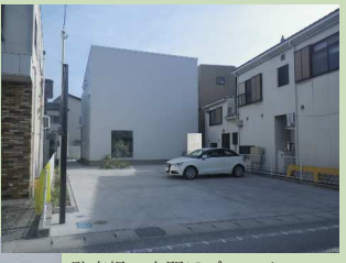
駐車場、玄関アプローチ コンクリート工事
